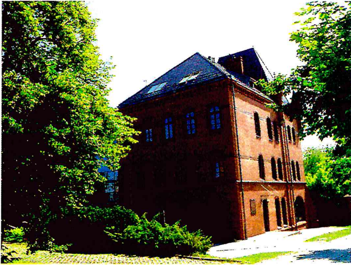
FOTO 1 – WIDOK OD STRONY ZAPLECZA
